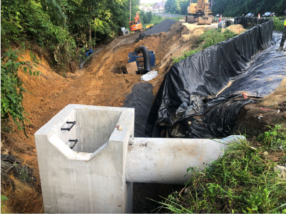
MD-2 Rescue (erosion repair)
